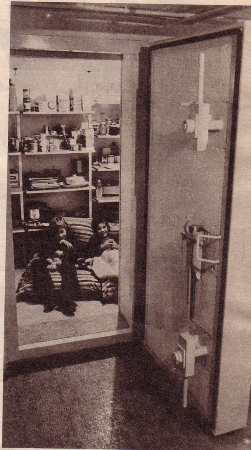
Entrada a uno de los cientos de refugios antiatómicos que se han construido en viviendas particulares en Suiza.
